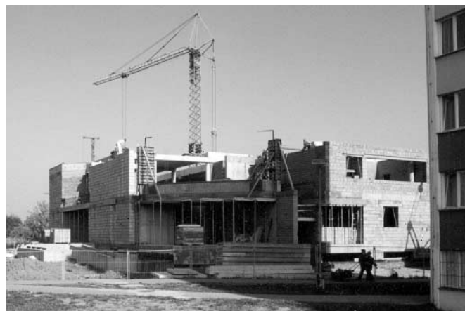
stavba nové budovy Univerzitní knihovny v Polabinách na jaře 1997
