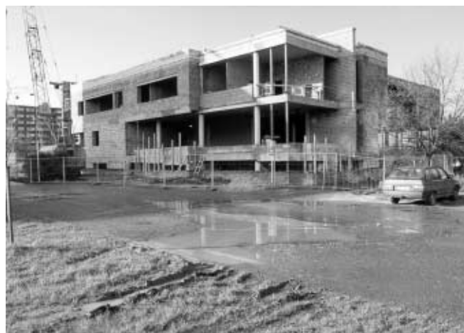
stavba nové budovy
