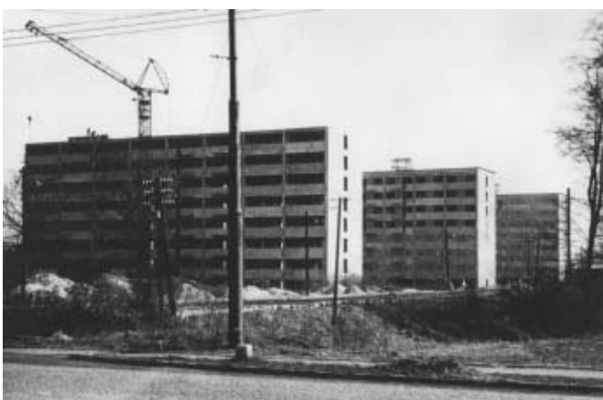
stavba kolejí v Polabinách
