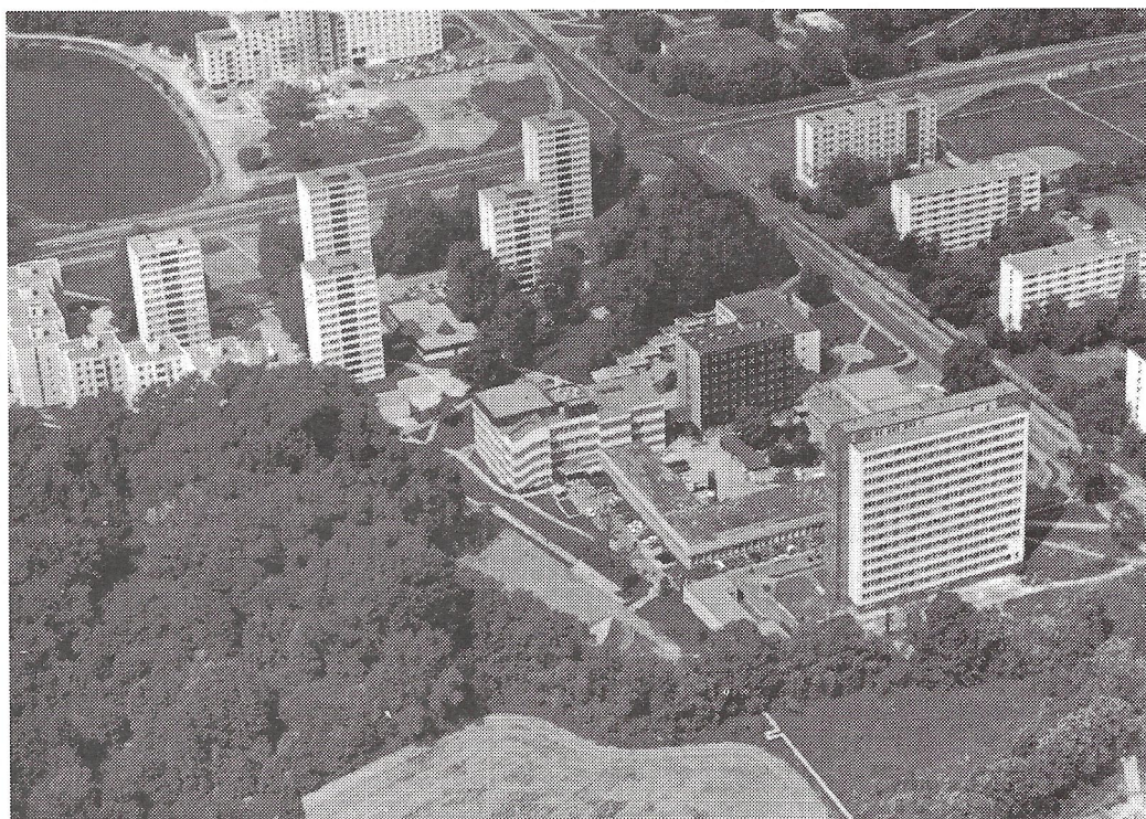
Univerzitní areál na Stavařově
