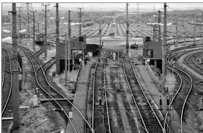
celkový pohled na svážný pahrbek a směrovou skupinu Zentralverschiebebahnhof Wien
