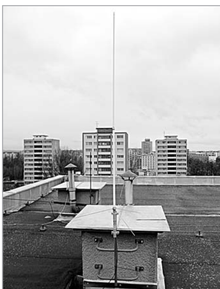
(zleva) obr. 1 – OK1SJ a OK1TPW při instalaci antény na střeše budovy DC obr. 2 – Anténa DIAMOND X-200N radioklubu OK1KID obr. 3 – QSL lístek potvrzující spojení se stanicí OK1KID
